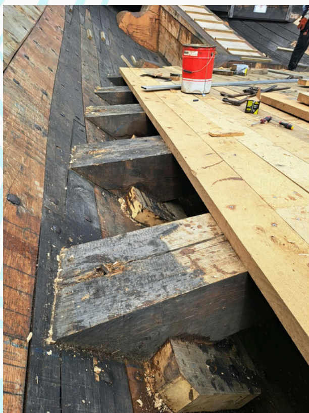
Galoches posées et fixées sous les barrots
