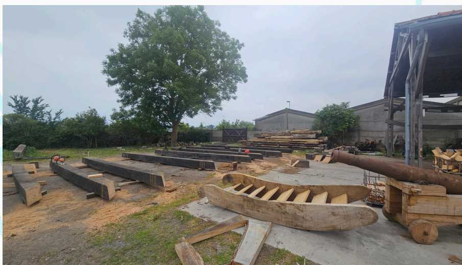
Barrots et escalier prêts au levage
