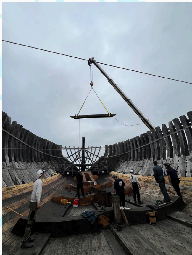
Levage d'un barrot de pont
