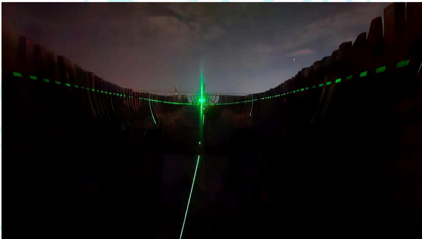
Traçage de la ligne de flottaison de nuit vue vers la proue (avant)
