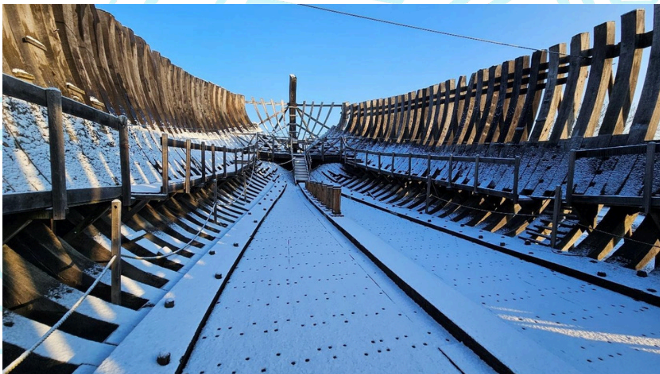
Février 2025 vue du Jean-Bart de la poupe vers la proue (de l'arrière vers l'avant)
