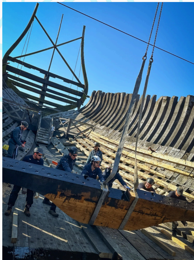
Levage des coulisses de l'emplanture de mât.
