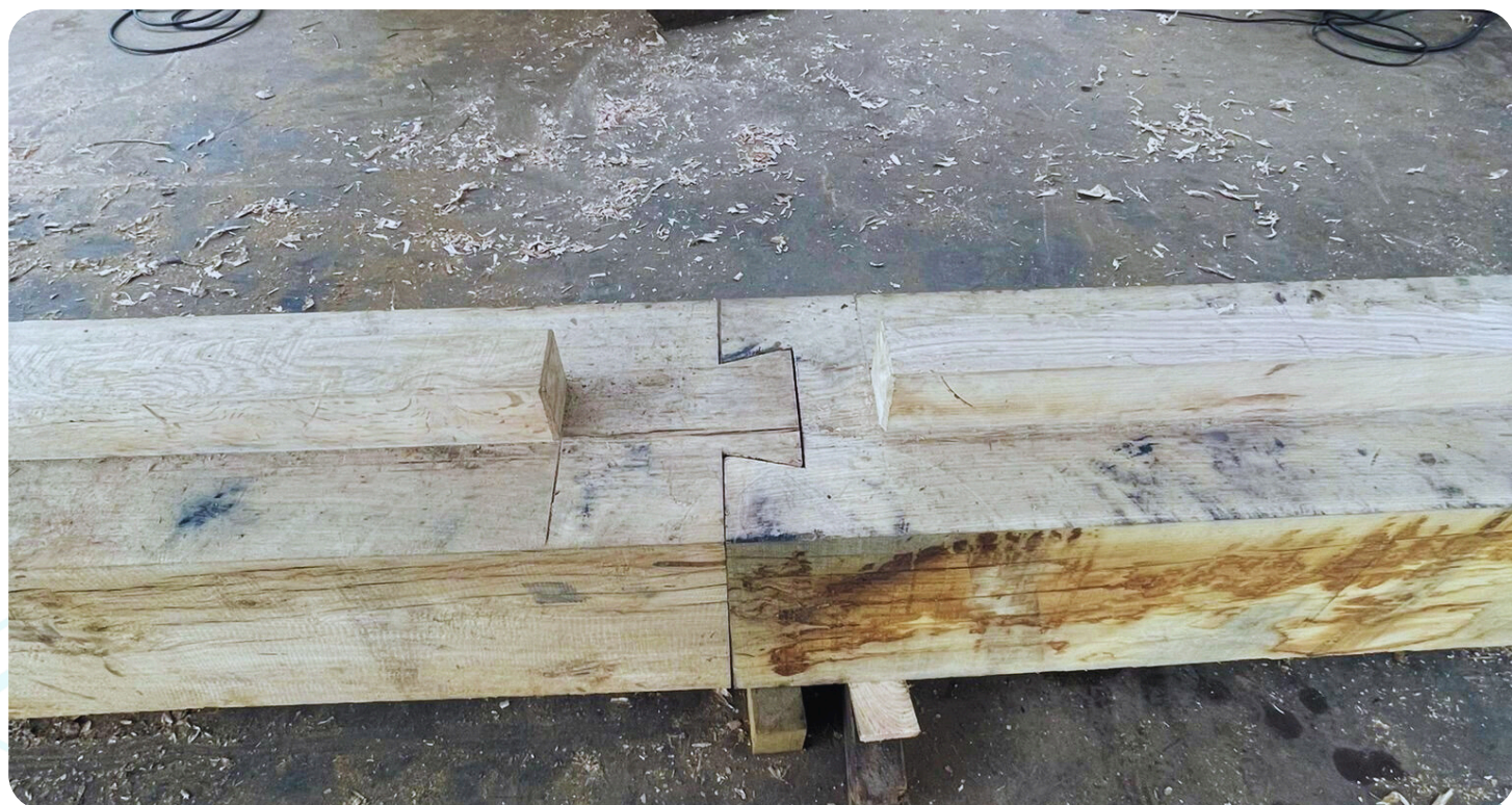
Assemblage des deux bras formant la base des varangues en queue d'aronde
