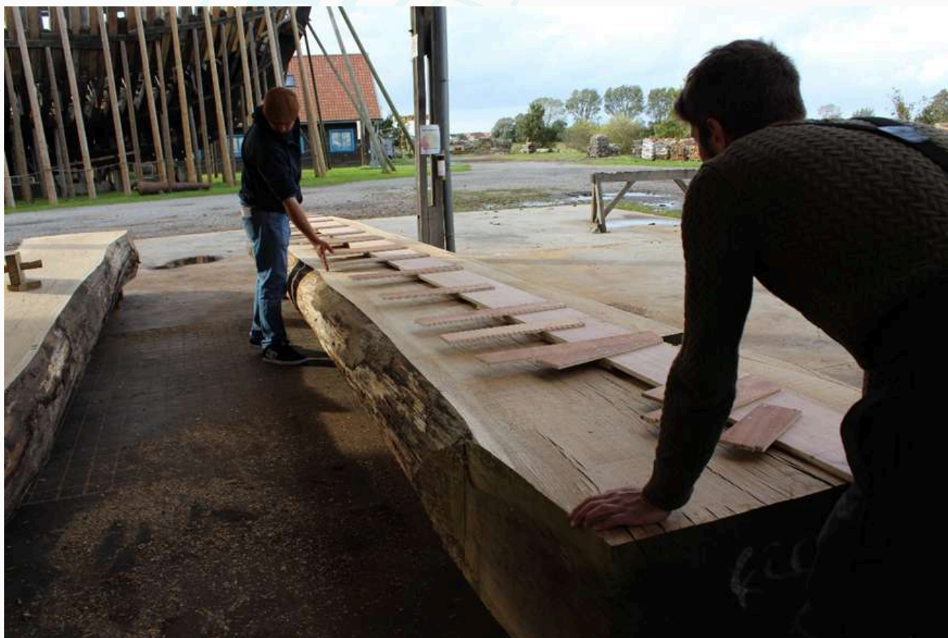
Deux charpentiers qui règlent le gabarit par rapport aux défauts du bois. Ici le but est d'éviter d'avoir de l'aubier dans la pièce finale.
