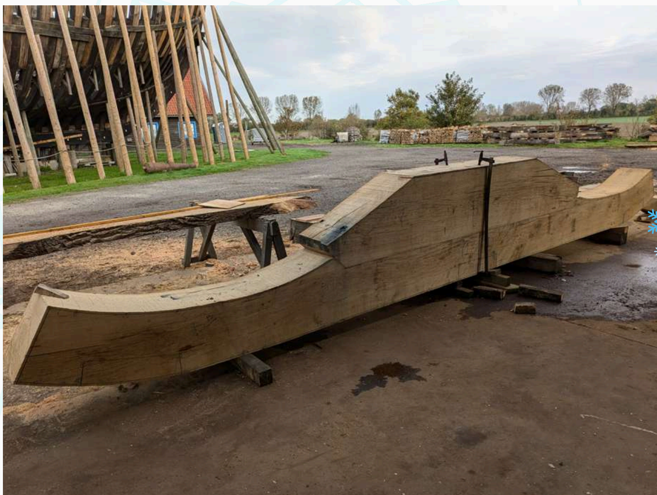
Assemblage du chapeau en tenon/mortaise
