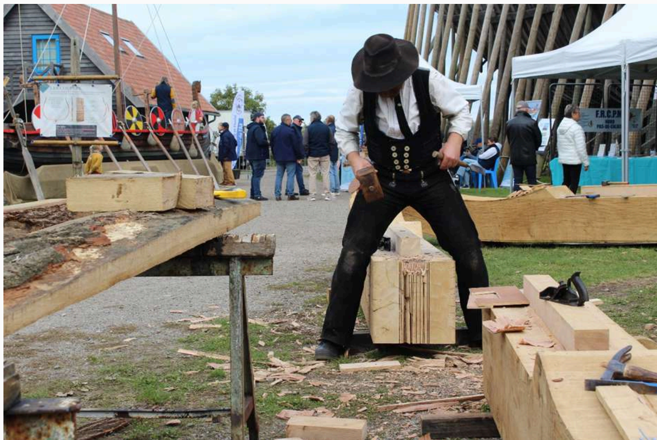
Nos charpentiers à l'œuvre sur les pièces d'emplature de mât. Durant toute la journée tout a été taillé entièrement à la main
