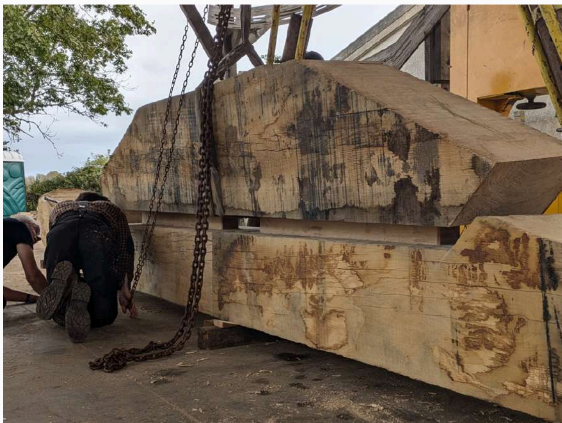
Assemblage du chapeau en tenon/mortaise
