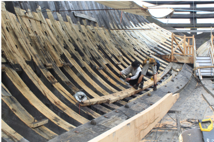
Traçage et fabrication du vaigrage sur l'arrière Tribord
