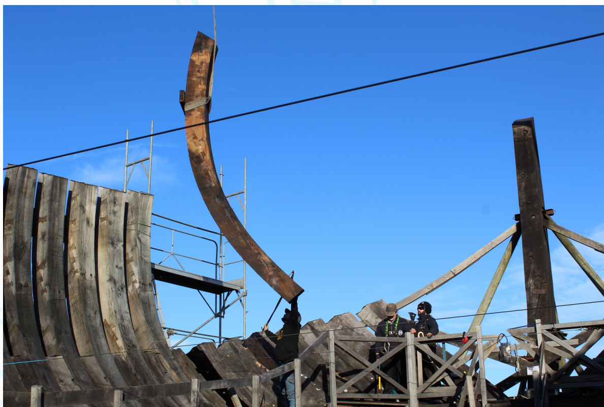
Levage des allonges Fav11 à Fav14 le 20 décembre 2023
