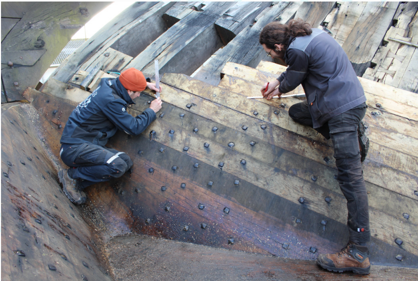
Gabariage pour la fabrication du 1er fourcat couché de l'arrière
