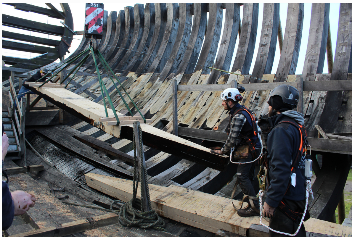
Levage des dernières pièces de serre d'empature bâbord le 20 décembre 2023
