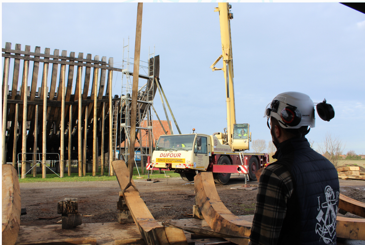
Grue Dufour pendant le levage du 20 décembre 2023
